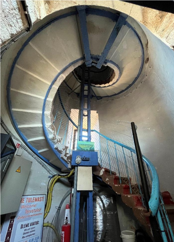
14–16. Interjäär. Sisemine metallkonsolidele toetuv paeastmetega keerdtrepp. Keskel pöördlaterna vastukaalu šaht. Metallpiirde puidust käsipuu ots on murdunud.
