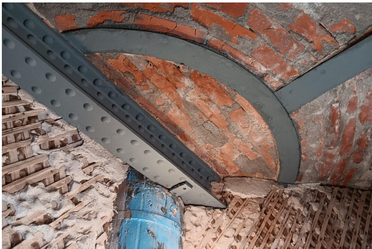
24. Interjäär. Valveruumi metallkonstruktsiooni vahele laotud tellistest vahelagi.
