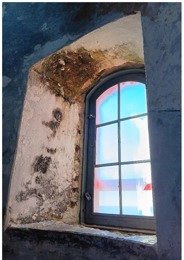
17–20. Interjäär. Krohvitud seinte trafafettmaalingutega paneel. Akende metallraamid, irdunud krohv ja kahjustused aknapõskedel.
