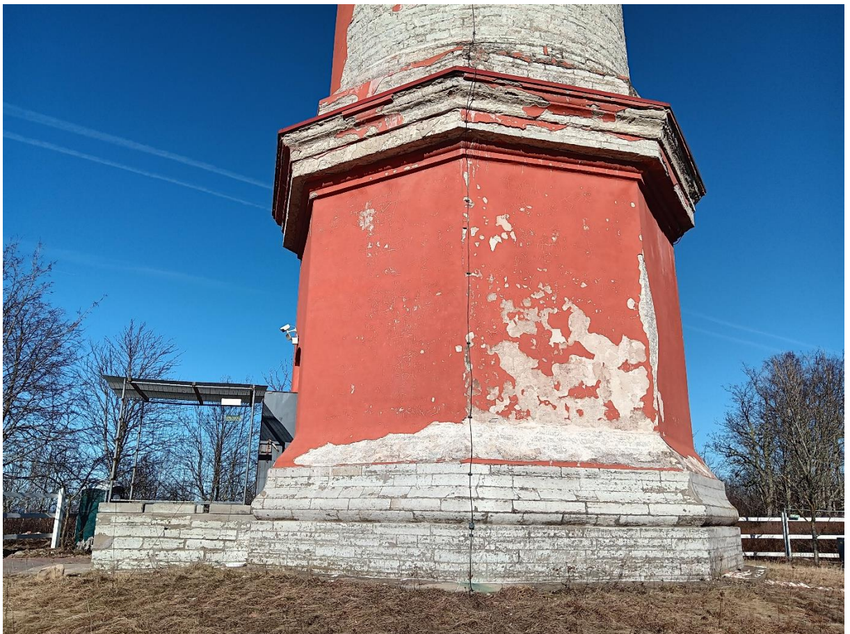
7–8. Profileeritud sokkel, kaheksatahuline sokliossa ja vahekarniis. Vaated põhja ja lõuna poolt.
