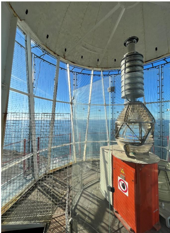
34–36. Laternaruumi mõlemalt poolt plekiga vooderdatud kuppel, klaasitud metallkarkass, malmplaatidest põrand. Väljaspool laternaruumi piirdega vaateplatvorm.
