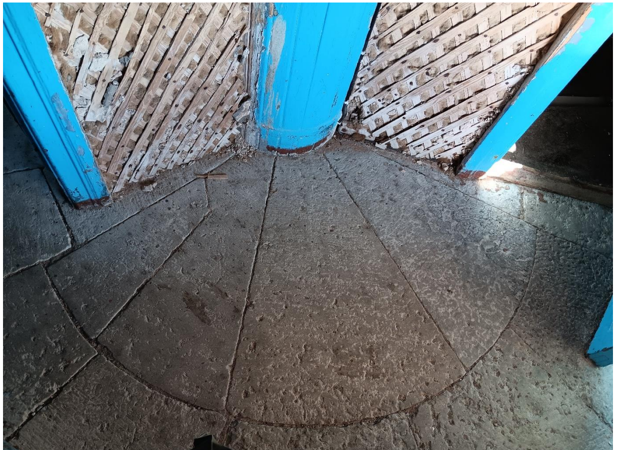
21–23. Interjäär. Laternaruumi all oleva valveruumi algupärased tahveldisega puituksed, profileeritud laudadega kaetud keskosa, paeplaatidest põrand. Ukse ja akna vahel on kinnimüüritud küttekolde kaarsillusega ava.
