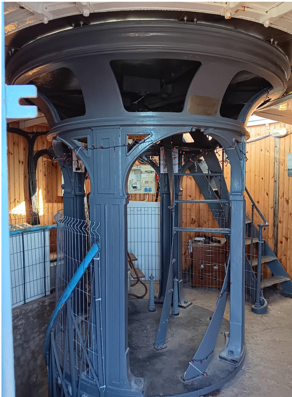
27. Interjäär. Laternaruumi alumine osa. Algupärane pöördlaterna alus, laternaruumi viiv metalltrepp. Ruumi seinalaudis on uuendatud 2001. aastal.
