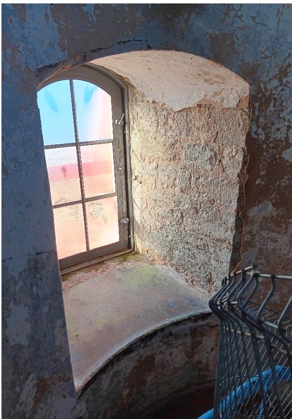
17–20. Interjäär. Krohvitud seinte trafafettmaalingutega paneel. Akende metallraamid, irdunud krohv ja kahjustused aknapõskedel.
