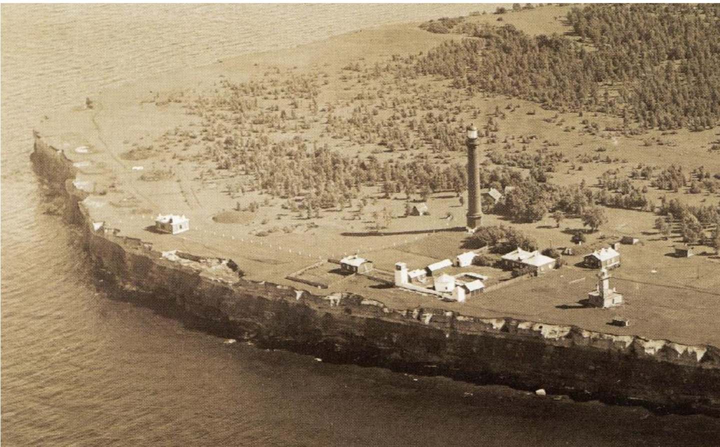
4. Aerofoto 1932. aastast. Allikas: Pakri tuletorni tehnilise hoone seisukorra hinnang ja ettepanekud hoone korrastamiseks. Heli Toms, Eesti Kunstiakadeemia Arhitektuuri konserveerimise ja restaureerimise täiendkoolituskursuse lõputöö, 2020.
